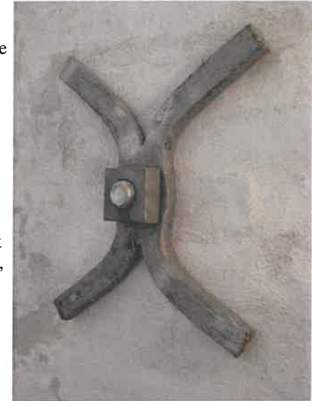
Nyrestaureret muranker Selde kirke i Salling
